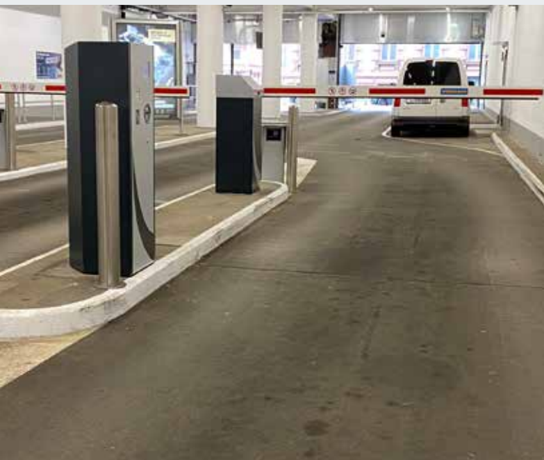
Anlægsbeskyttelse indvendig, f.eks. betalingsautomater, bomme
