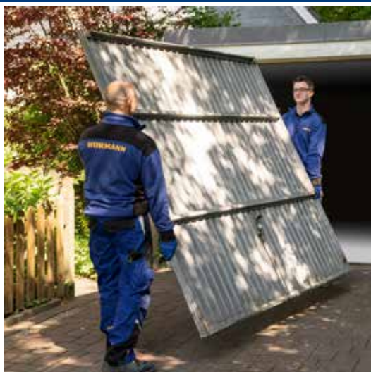
Afmontering og bortskaffelse af den gamle port
